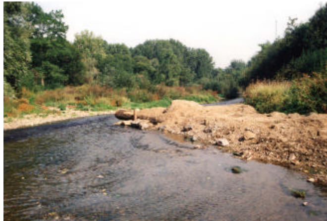
Einbau von nicht standortgerechten Pappeln als Totholzstrukturen und Strömunglenker
